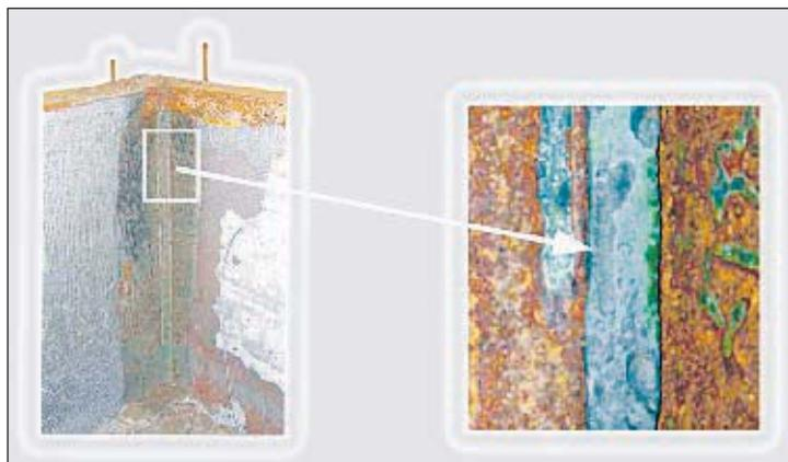
Рис. 2. Поверхность ванны в зоне сварного шва после года эксплуатации
